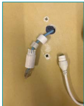
⑥敷設したLANケーブルに防水コネクタを取付け、カメラ側と接続する ※カメラの落下に注意
