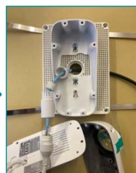
④UTPIに防水コネクタを通し、カメラに接続する
