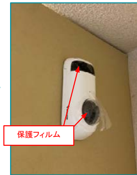
⑩完了 ※レンズカバーとLED照射部のフィルムを剥がしてください。
