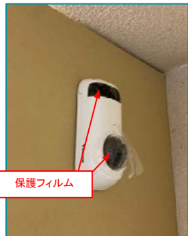
⑩完了 ※レンズカバーとLED照射部のフィルムを剥がしてください。
