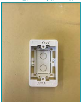
①モール用スイッチボックスを設置面に固定する ※サンプルでは未来工業(MSB-F1SSW)
