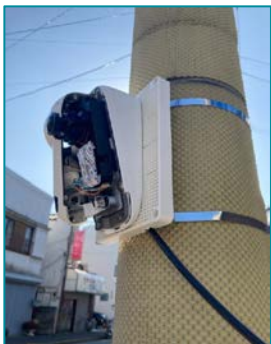
⑥カメラを柱に固定し、画角調整を行う
