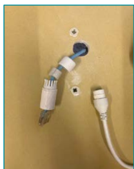
⑥敷設したLANケーブルに防水コネクタを取付け、カメラ側と接続する ※コネクタの順番に注意
