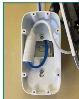
②スイッチボックスにTILTプレートを固定し、敷設したLANケーブルをカメラと接続する
