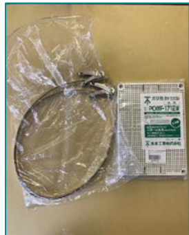
①未来工業製ポリ台(POWF-1712W) ステンレスバンド10mmを用意
