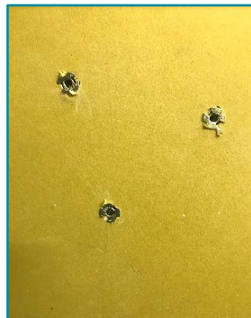
③アンカー本体を取り付ける ※ビスで固定する場合は下穴は不要です。
