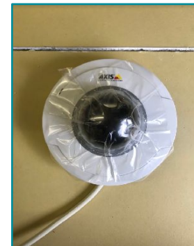
⑤カメラを取付金物に固定して完了 ※フィルムを剥がして画像を確認しながら画角を調整してください。
