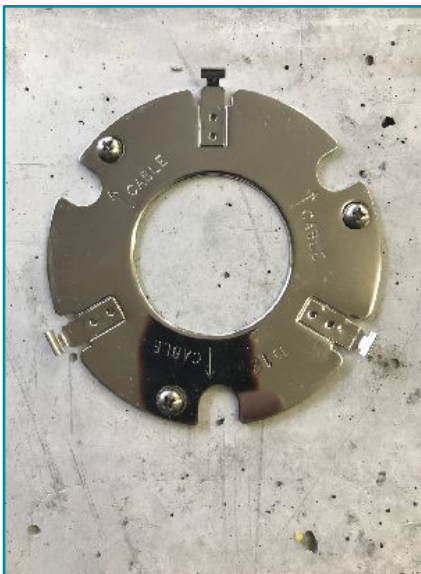
④取付金物を設置面に固定する
