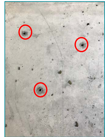
③下穴をあけプラグを埋め込む ※○印3か所
