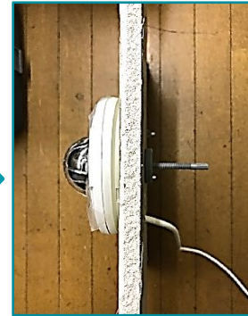
④カメラを固定具で固定する
