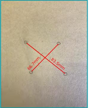
⑦ボードアンカー及び通線口の墨出しをして開口を開ける
