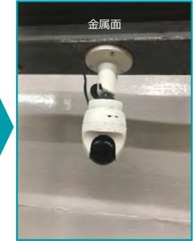
⑤LAN(UTP)ケーブルを接続し、画角を調整して完了
