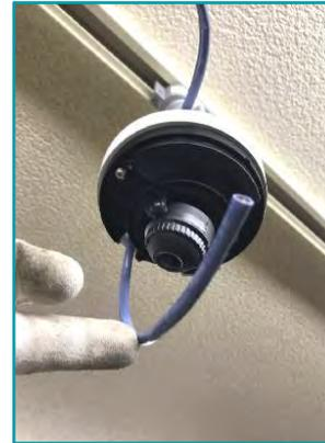
・LANケーブルをコンジットバックボックスの背面から通線する
