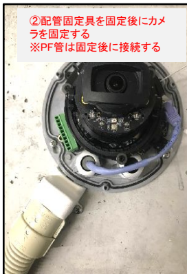
⑧LANケーブルをLANポートに接続し、カメラを固定する ※LANポートに接続後は予長を調整しゴムパッキンを締める
