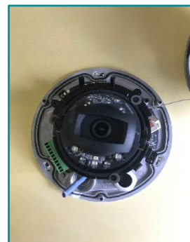
⑧カメラを設置しLANケーブルを通す
