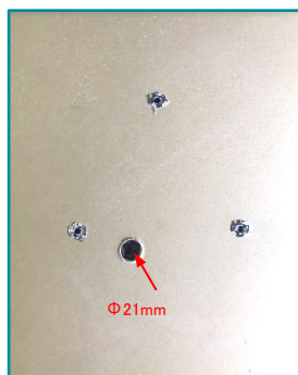
⑥通線口を開けてボードアンカーを取り付ける ※サンプルではネジ径M4の開脚式のボードアンカーを使用しています。
