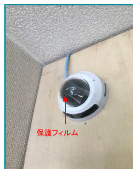
⑦カバーを取り付けて完了 ※設置後はカバーの保護フィルムを剥がしてください。
