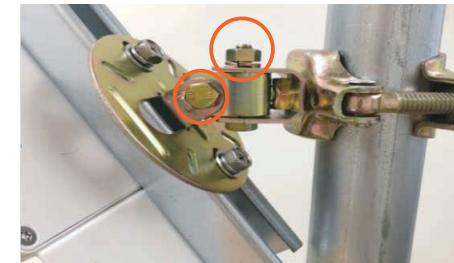
※Safie GO本体の取り付け角度を、単管パイプに対して45度以内に設置してください。45度を超えて設置すると本体背面から漏水し故障の原因になります。
